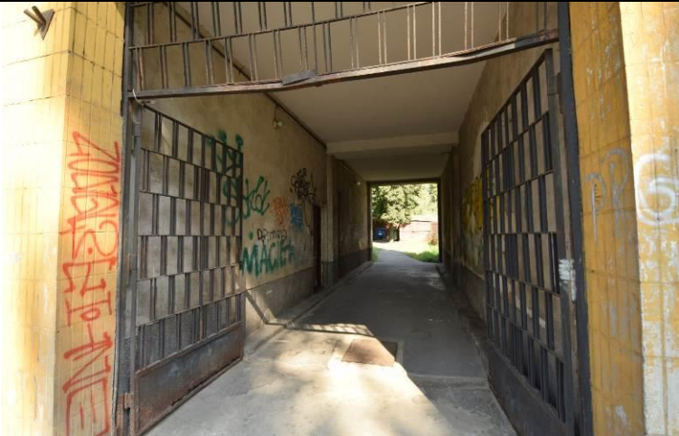
Przejazd bramny z zachowaną oryginalną bramą.
