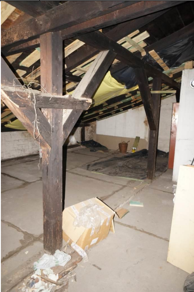
Więźba dachowa płatwiowo-kleszczowa.
