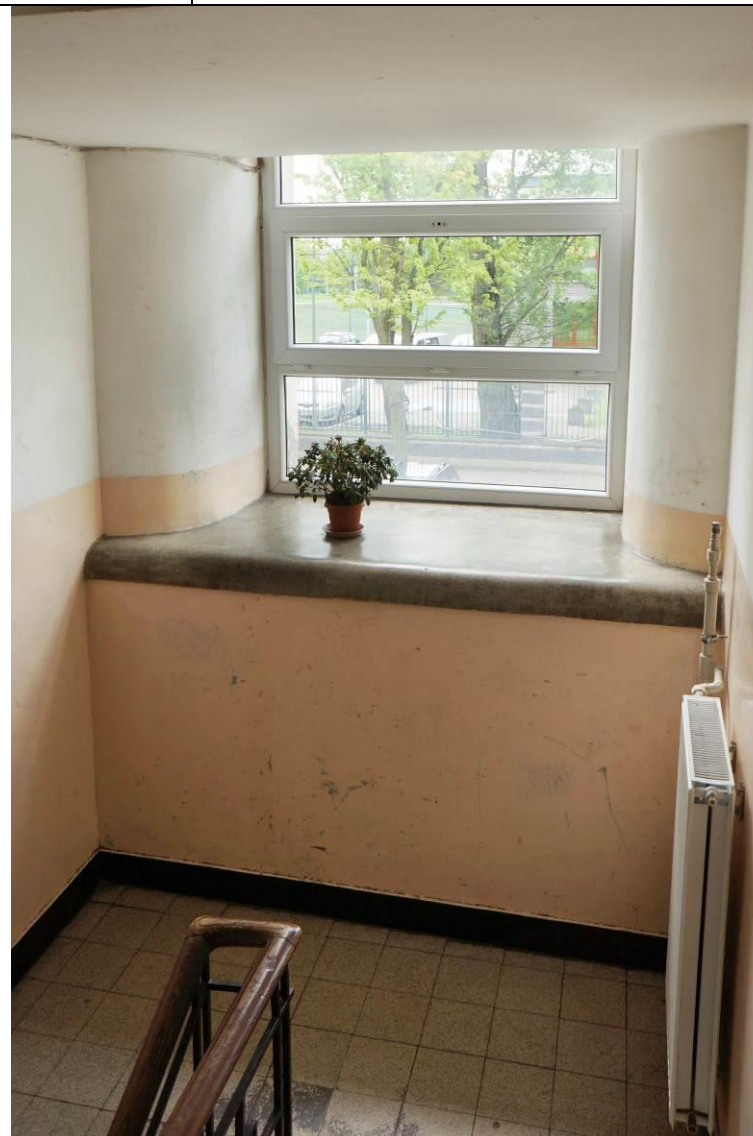
Spocznik klatki schodowej.
