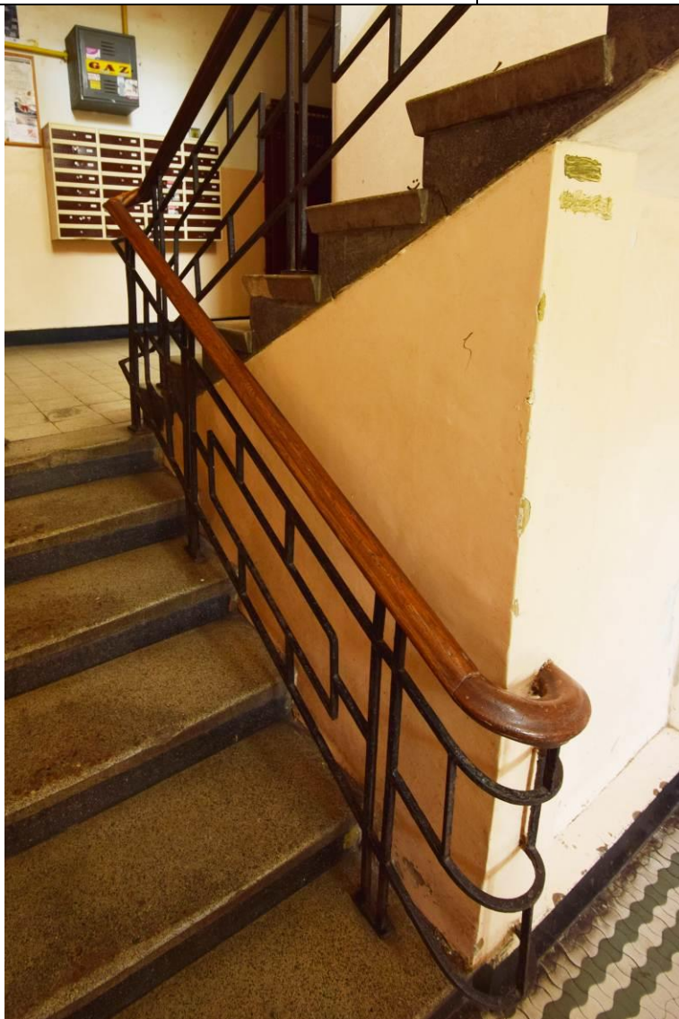
Parter klatki schodowej.
