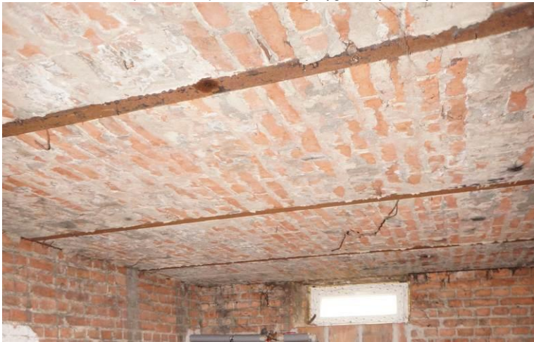
Piwnica. Strop Kleina.
