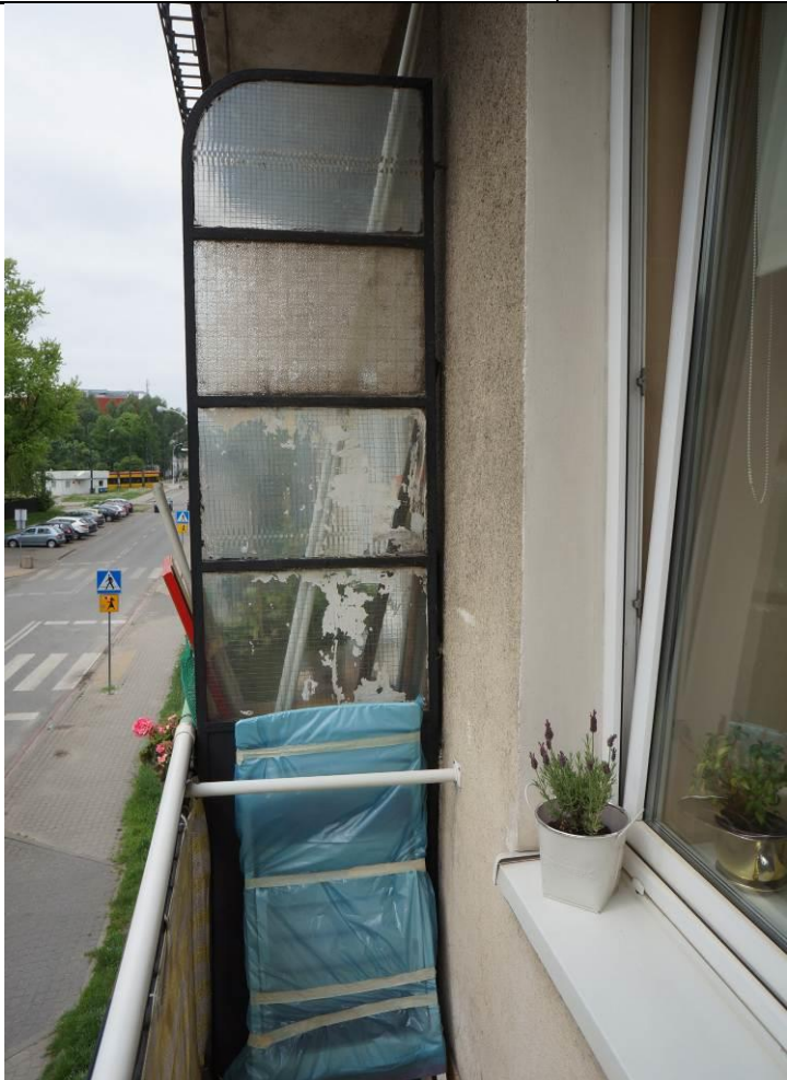
Oryginalne przepierzenie balkonu od strony fasady.
